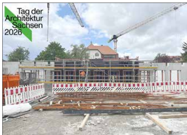
Baustelle Lernwelten Gymnasium
